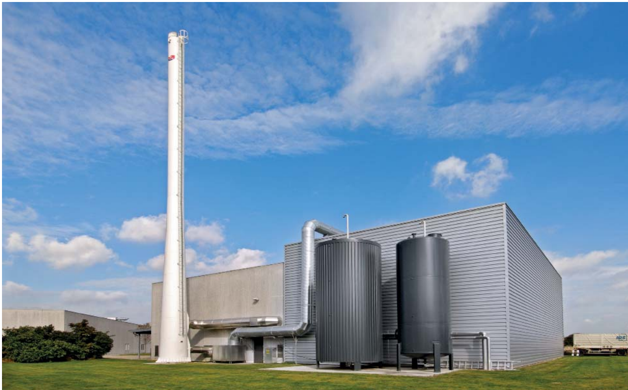
Vejen Varmeværk er et typisk dansk fjernvarmeverk, hvor varmen kommer fra flere kilder. I Vejens tilfælde affaldskraftvarme, biomasse og naturgas. Måske et eksempel på den rette vej frem for Europas energiforsyning? Foto: Jørgen Schytte.
