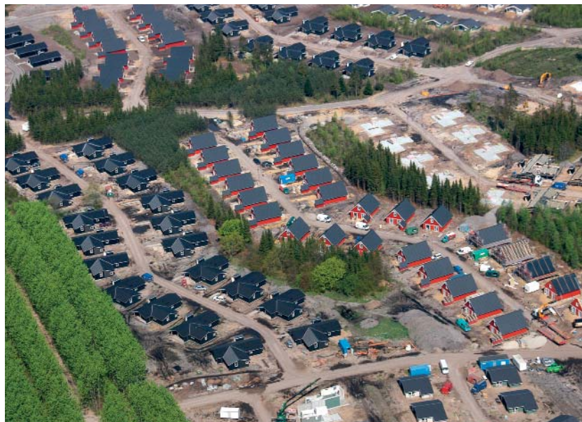
Lalandia Billund er nærmeste nabo til Legoland. Når de sidste huse bliver bygget i løbet af de næste par år, vil Billund Varmeværk have mere end fordoblet antallet af forbrugere, når antallet af tilslutninger går fra 1.400 til 2.900. Foto: Bjarne Sig Jensen, Billund Luftfoto.
