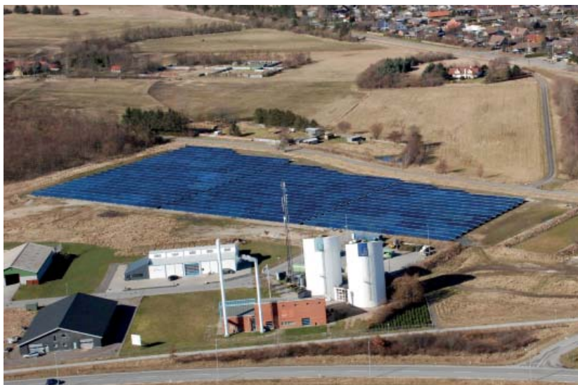
På grund af de mange solskinstimer i april har anlægget i Strandby fået en forrygende start, hvor det har leveret 70 procent mere energi end forventet. Foto: Strandby Varmeværk.
