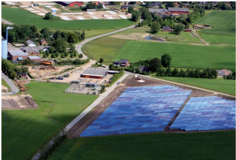
Med sine godt 10.000 m 2 er solvarmeanlægget i Gram det største af de tre, der netop er indviet. Det kan dække cirka 17 procent af byens varmebehov. Foto: Gram Fjernvarme.
