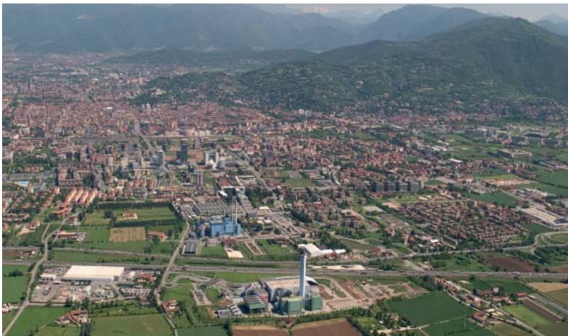
Fjernvarmeværket i Brescia omfatter både et traditionelt gasfyret kraftvarmeværk (den blå bygning), en biomasselinjje og et affaldsforbrændingsanlæg (den grønne bygning). Foto: AIRU.
