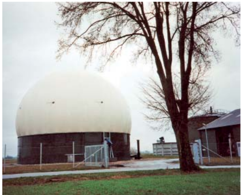
Et biogaslager på et biogasfællesanlæg. Anlæggene arbejder med svagt overtryk og består oftest af en "gaspose" indeni en stabil og vejrbestandig yderskal.
