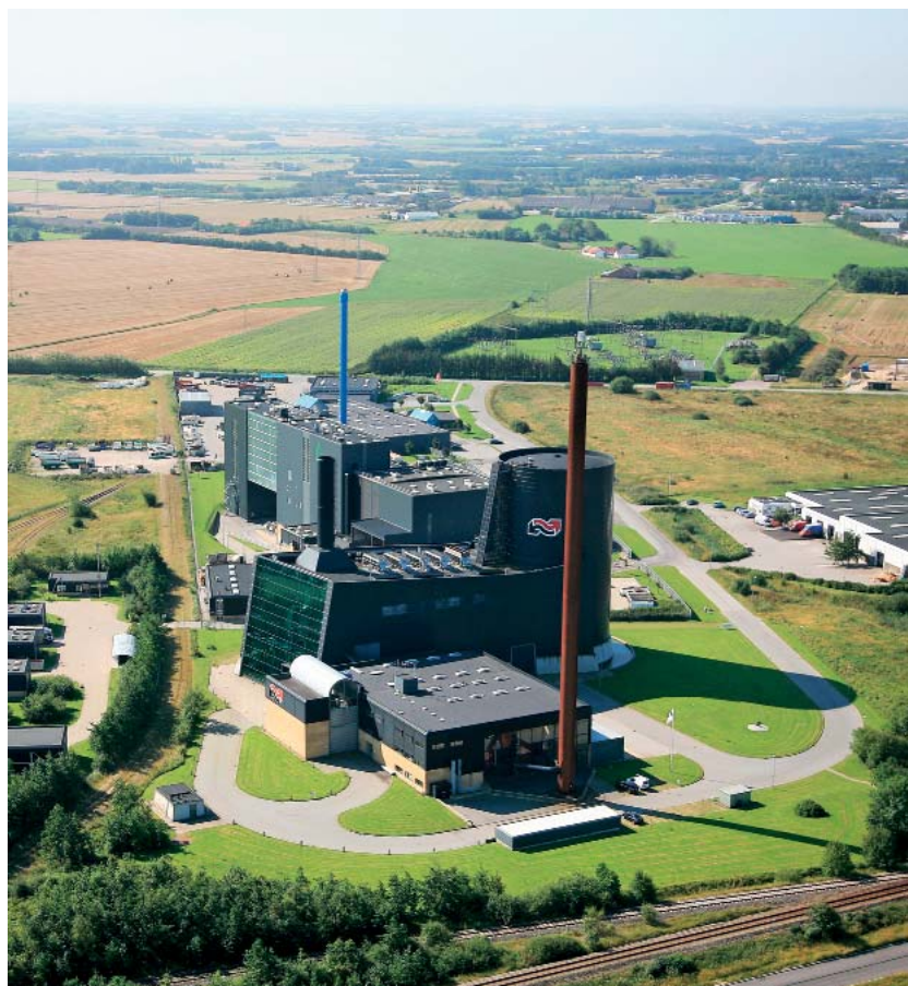
Siden Hjørring Varmeforsyning i 2006 installerede et temperaturstyringsystem, har varmeforsyningen sparet 1,5 millioner kroner om året. Foto: Hjørring Varmeforsyning.
