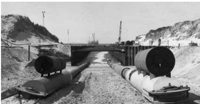
Dansk naturgas fra Nordsøen har været anvendt som energikilde herhjemme siden 1984. Fotoet er fra byggeriet af landgangen ved Kærgård Plantage. Foto: Dong arkivet, Gasmuseet.
