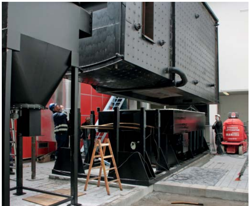
Trods dårligt vejr med regn og kraftig blæst lykkedes det at få alle de store komponenter sænket ned, hvorefter taget igen kunne monteres. Foto: Græsted Fjernvarme.
