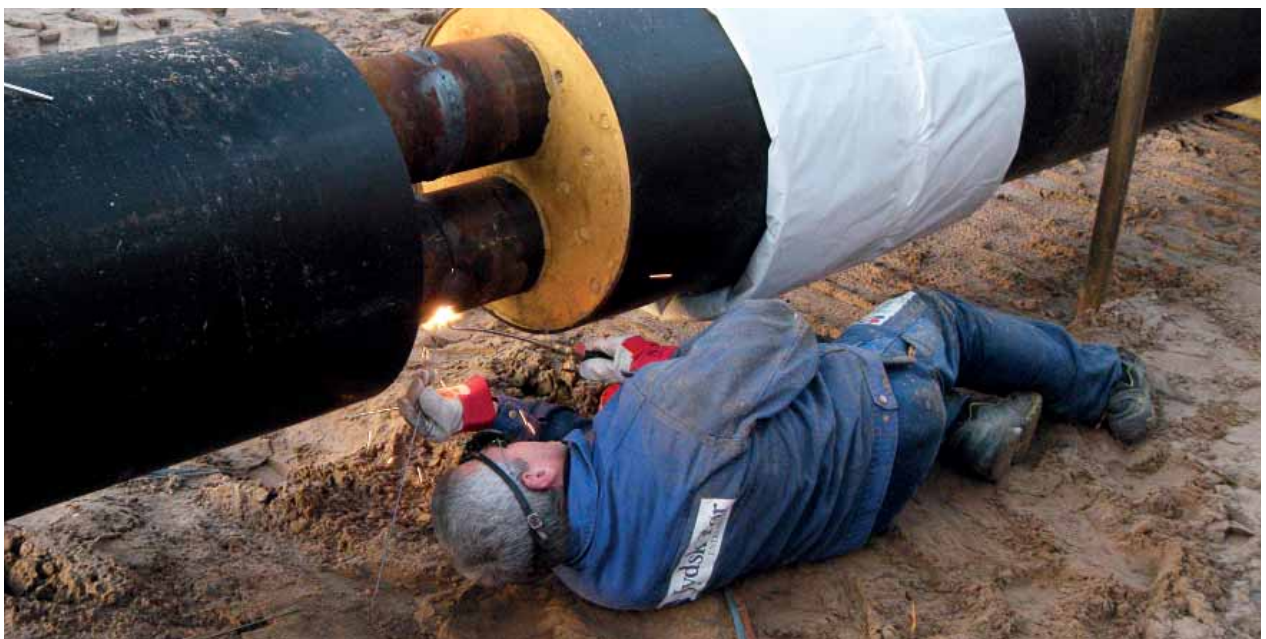
Fjernvarmen skal bredes ud til endnu flere danskere, hvis de danske klimamålsætninger skal indfries. Varmeplan Danmark 2010 rummer en konkret udbygningsplan for, hvor i landet fjernvarmerørene skal lægges i jorden. Foto: Mogens Uhrskov.
