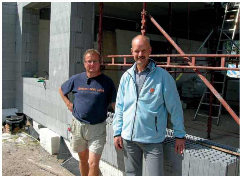
Henrik Rødtnes (tv), der er ved at opføre et hus i lavenergiklasse 1, har undersøgt mulighederne for opvarmning grundigt. Valget faldt på fjernvarme frem for en varmepumpe, og det glæder direktør Carl Hellmers, Fredericia Fjernvarme. Foto: Kenn Gade Thomsen.
