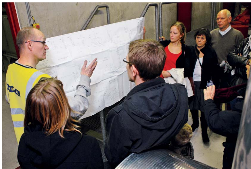
Akademiingeniør Henrik Fürbringer havde travlt med at fortælle om fjernvarmen, da Københavns Energi, VEKS og CTR havde inviteret på en oplevelse under jorden. Her er vi i veksler- og booster-pumpestationen under Forum på Frederiksberg. Foto: Flemming L. Rasmussen.
